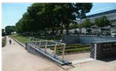
POSER DES REPÈRES ET DES ÉCHELLES DE CRUES
